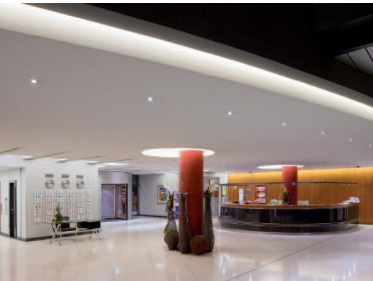
↑ Die 35 Meter lange Lichtvoute erhielt jetzt eine LED-Lösung, die im Vergleich zur vormaligen Beleuchtung das Zehnfache an Anschaffungskosten und 70 Prozent der Energie einspart.
