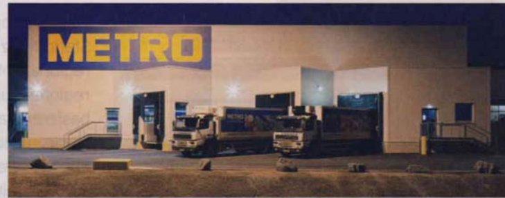
Rampen-Licht: Auch der Außenbereich des österreichischen C+C-Markts wird mit Leuchtdioden illuminiert.
