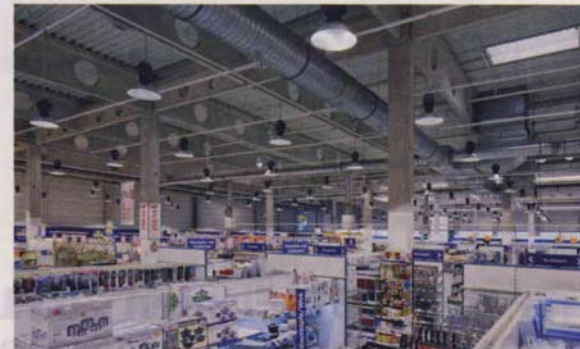
Grundbeleuchtung: Der Großmarkt in Wiener Neustadt wird von 294 je 100 Watt starken Industrie-Pendelleuchten im Lichtton „Neutral-Weiß“ in Szene gesetzt.
