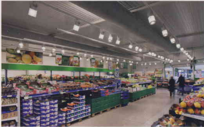
▲ Die Frische-Abteilungen werden mit Spots und Downlights akzentuiert
